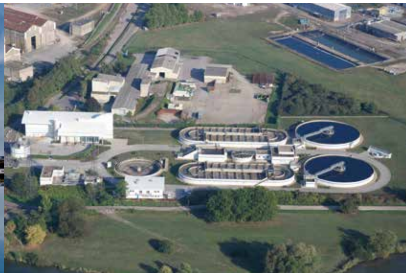
Traitement des eaux usées
